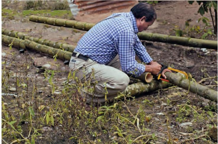
Figura 69. Calibrado y corte de cañas.
